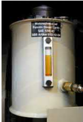
Grafik 2-3 Kontrolle Ölstand Lüfterantrieb
