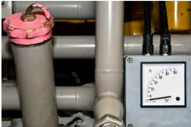
Grafik 1-27 Einfüllstutzen mit Füllstandsanzeige
