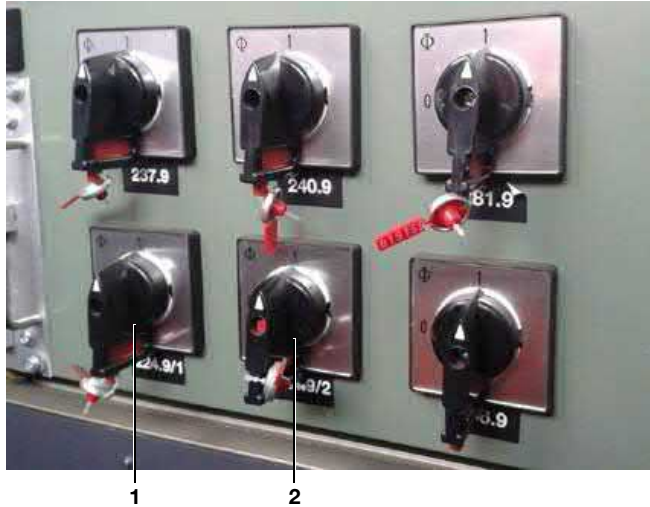
1 Abtrennschalter 224.9/1 2 Abtrennschalter 224.9/2
