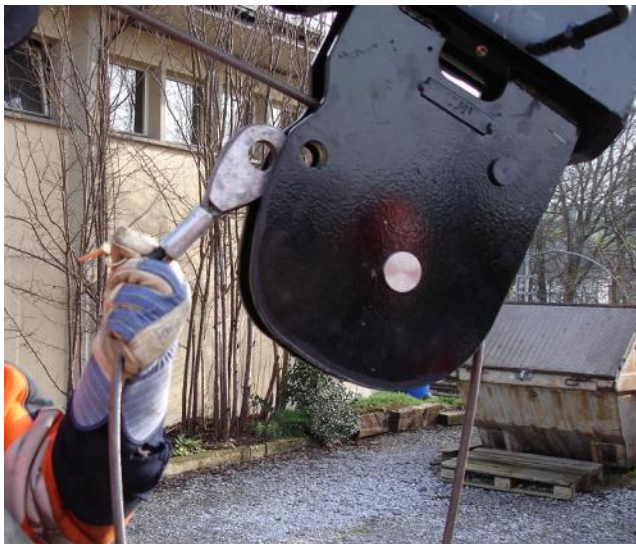
Seilmontage am Rollenkopf
